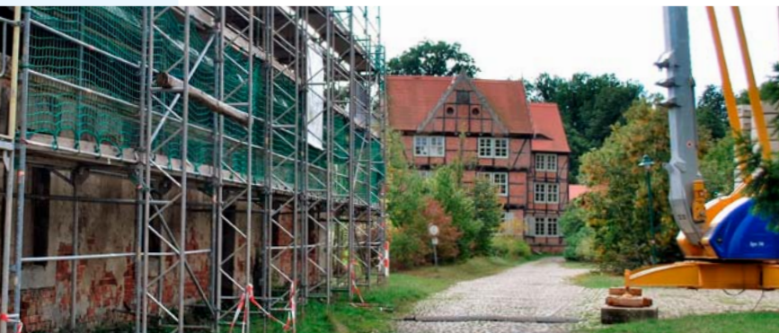
Die Sanierungsarbeiten am Brauhaus Briest schreiten voran und lassen das Gesamtensemble bald wieder in vollem Glanz erstrahlen.
