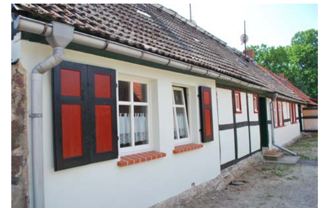
Ausbau einer Ferienwohnung am Altmarkrundkurs in Lüderitz
