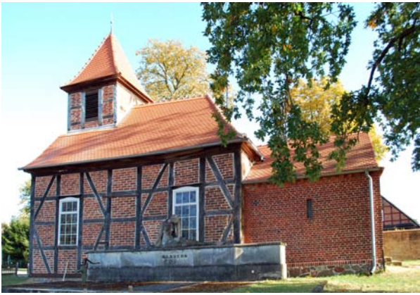
Verfugung der Kapelle Köckte als Erhaltungsmaßnahme des historischen Dorfmittelpunktes
