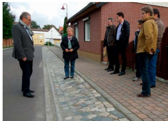
Allein in Grieben wurden drei Wegebaumaßnahmen realisiert. Ortsbürgermeisterin Rita Platte (Mitte) zeigte LAG-Akteuren, wie hier am Mühlenschlag, ein Resultat.
