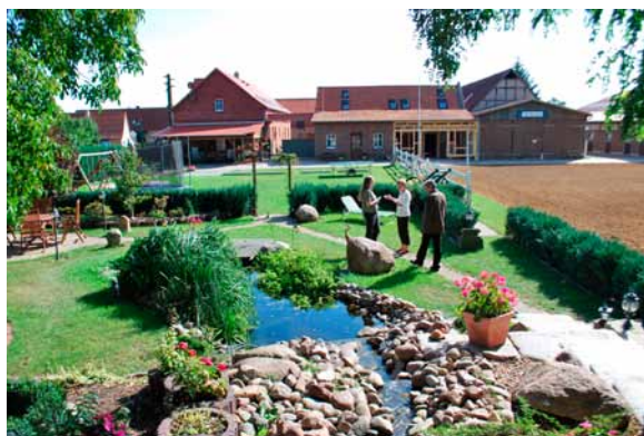
Die Reitanlage Albrecht in Buch während der Bauphase des Leader-Projektes im letzten Jahr
